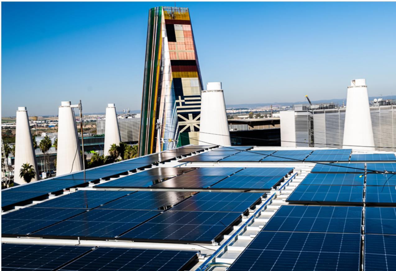
En el edificio de la sede se ha llevado a cabo una instalación solar fotovoltaica con acumulación de 58,5 kWp. Foto: Agencia Andaluza de la Energía.
